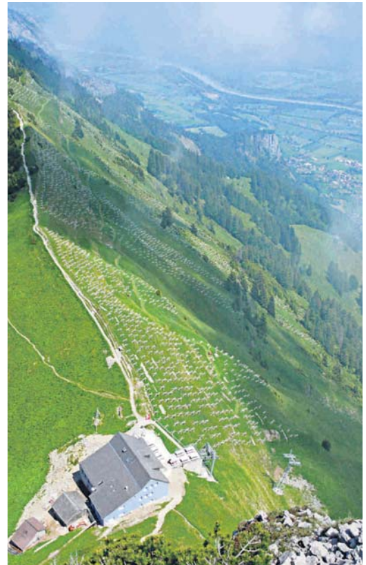
6000 Dreibeinböcke zum Schutz vor Lawinen: Blick von der Staubererchanel auf das Aufforstungs- und Verbauprojekt Stauber.
