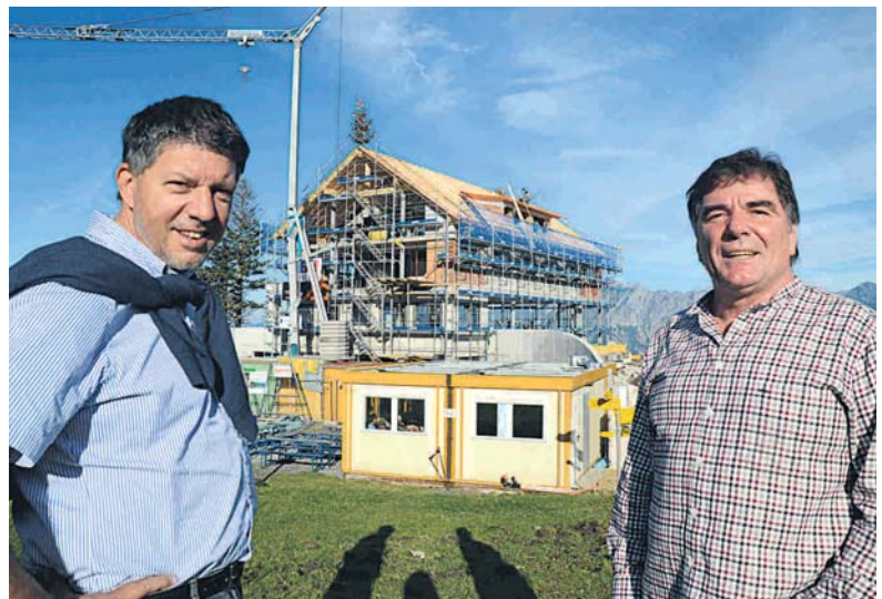
Berghaus: Ortsgemeindepräsident Heini Senn (links) und Architekt Paul Haltinner zeigen den Rohbau. Bild Hansruedi Rohrer
